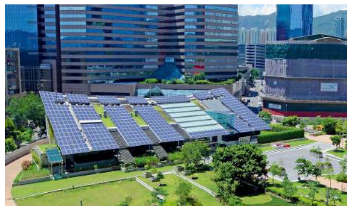
Nền tảng quản lý tòa nhà tập trung CIC
