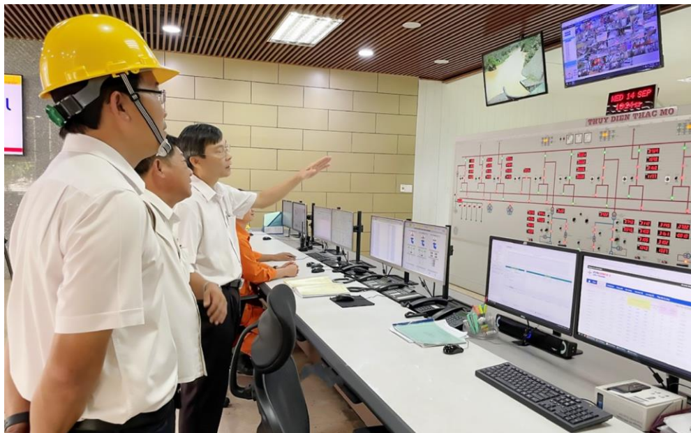
Hệ thống SCADA tại Trung tâm điều khiển có thể thao tác nhận lệnh và thực hiện lệnh điều độ hoàn toàn trên máy tính, giảm được khối lượng công việc thường ngày của nhân viên vận hành
